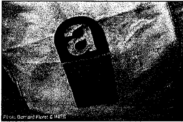
Étiquetage réglementaire déchet contenant de l'amiante
